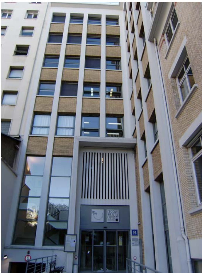
Edificio 105 Boulevard Raspail
